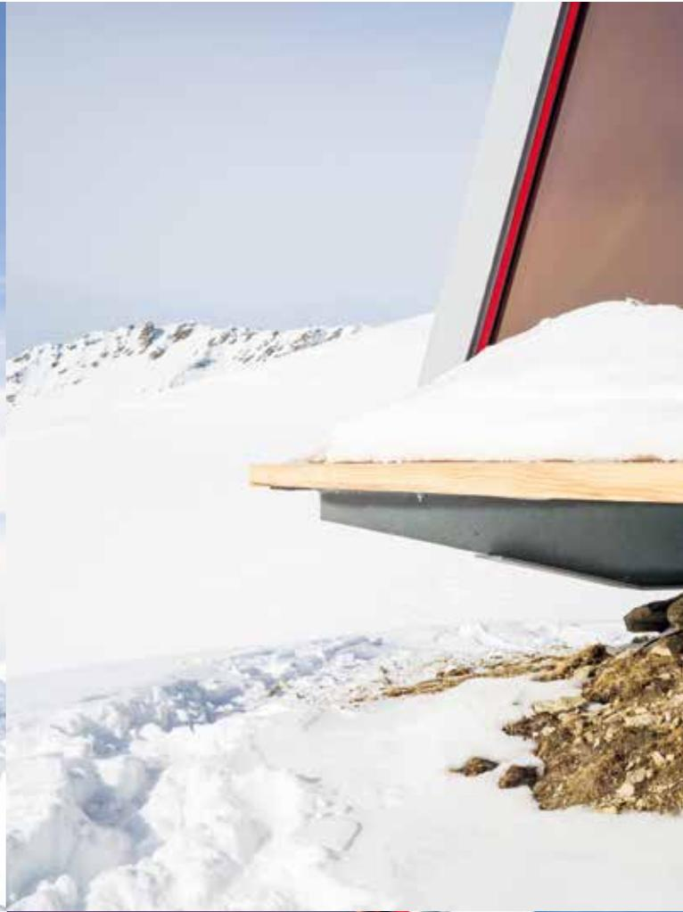
La tecnologia costruttiva è stata sviluppata in questo senso: un guscio strutturale composto da pannelli in CLT (Cross Laminated Timber) appoggiato su una base in acciaio che insiste su quattro plinti prefabbricati.
